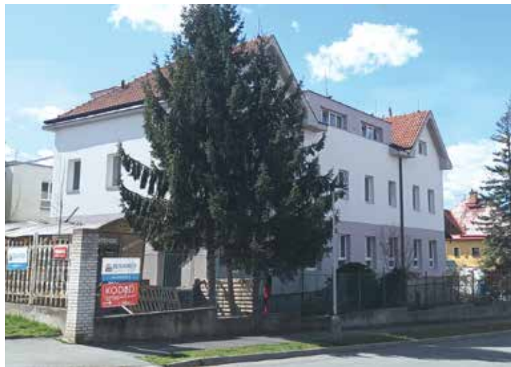
Od roku 2009 (vedlejší snímek) značně povyrosl smrk před budovou, zatímco její fasádu dnes zdobí nová omítka
