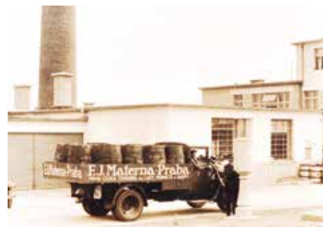
Zázemí hostivařské továrny s firemním vozem, cca 30. léta
