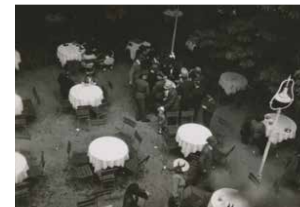
Netradiční pohled z otevřené galerie budovy do restaurační zahrady.
