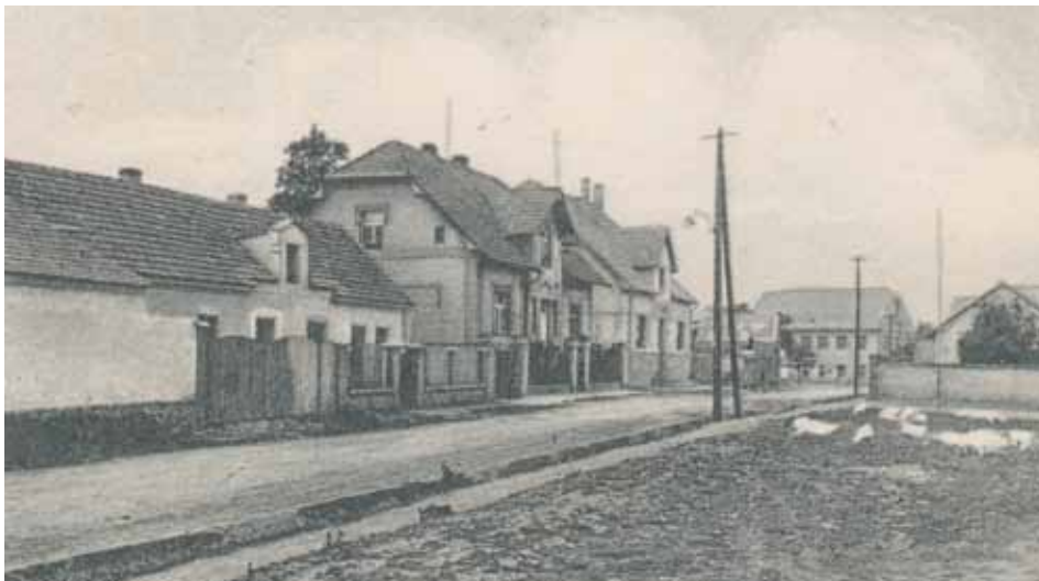
Vesnický ráz Horních Měcholup za první republiky zmizel během demoličních prací, které hostinec U Hervertů jen zázrakem přestál.
