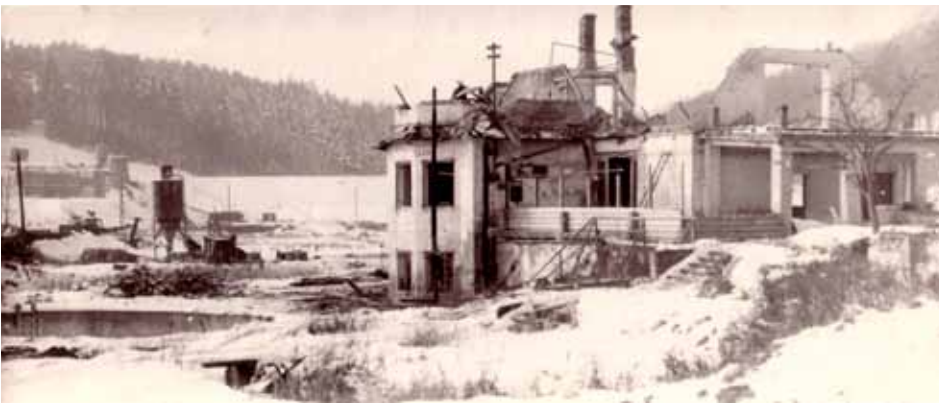
Smutný okamžik demolice mlýna, který na Botiči stál od 18. století
